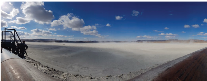
Abb. 1: Blick auf die Tailingsanlage in Erdenet
